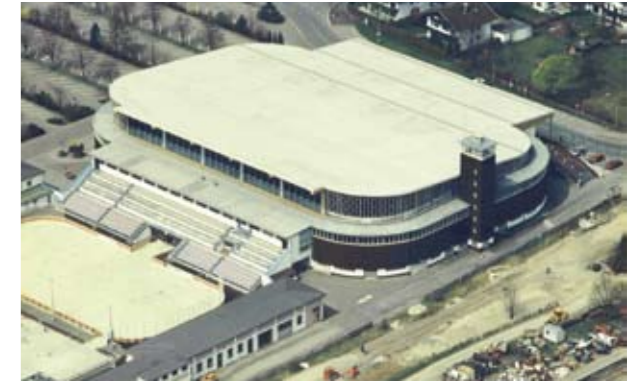
Olympia Eissporthalle Garmisch-Partenkirchen
