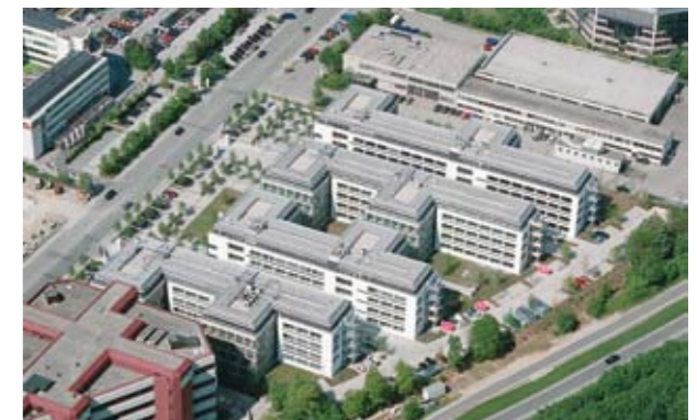
Büro im Park Unterföhring
